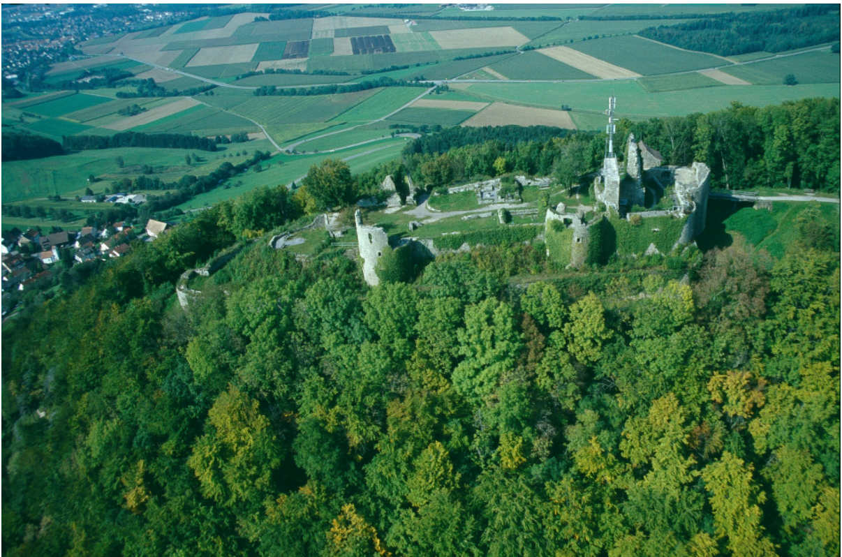
17 die Burg von Süden Richtung Klettgau gesehen
