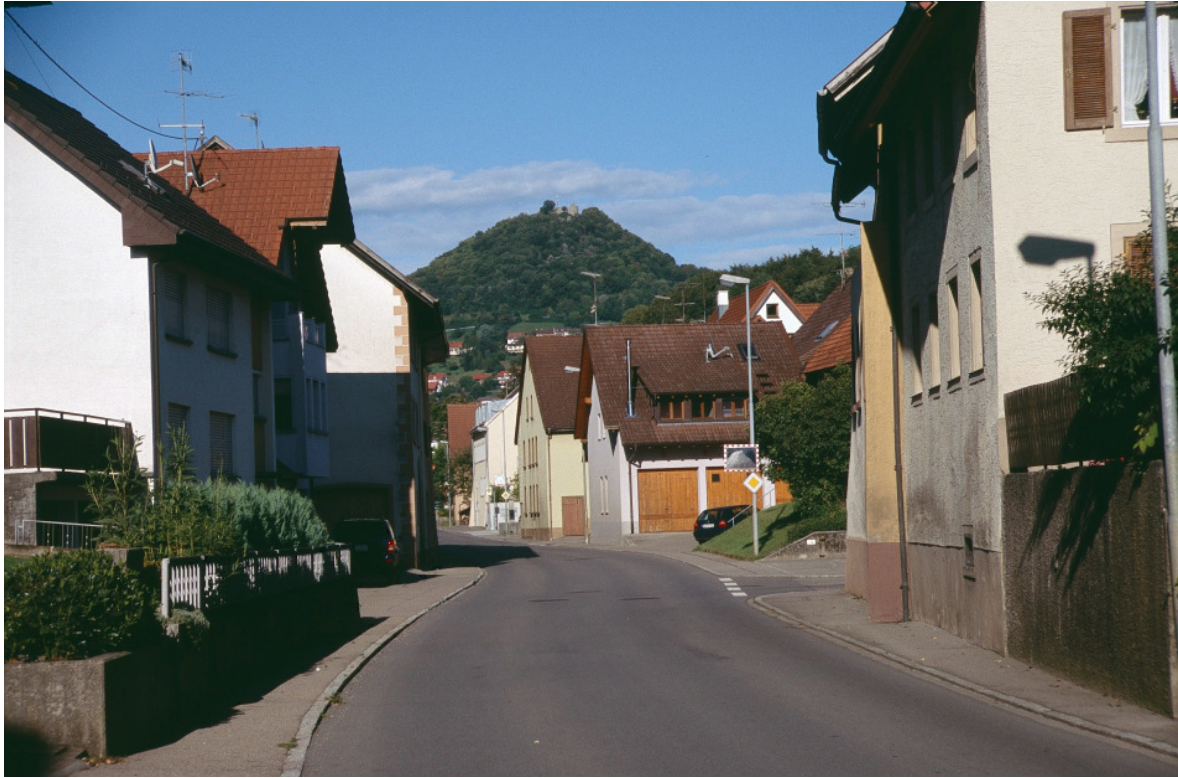
01 Ansicht von Westen aus der Ortsdurchfahrt Dangstetten
