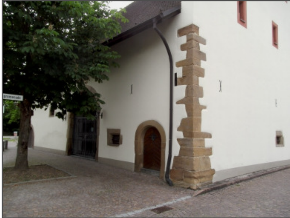
Das Gebäude aus Blickrichtung Westen mit der markanten Gebäudeecke und der Vorderfront mit den drei Toren.
