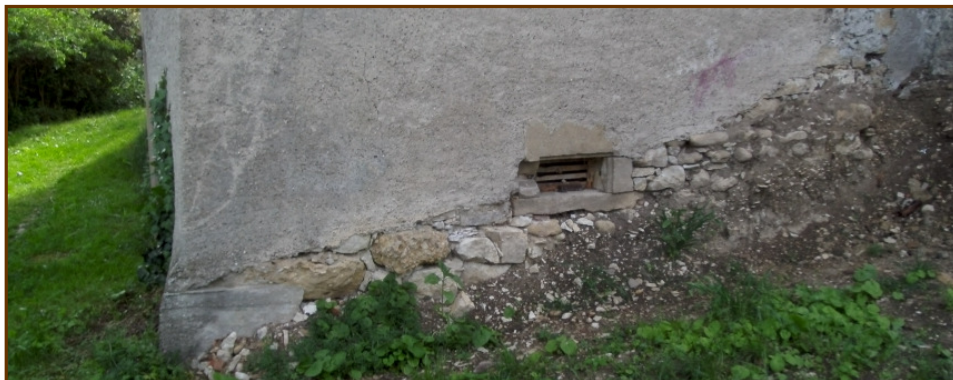
Die nordwestliche Ecke des Gebäudes mit dem Fundament, das aus Bruchsteinen besteht. Die Fugen sind offen, ohne Mörtel.
