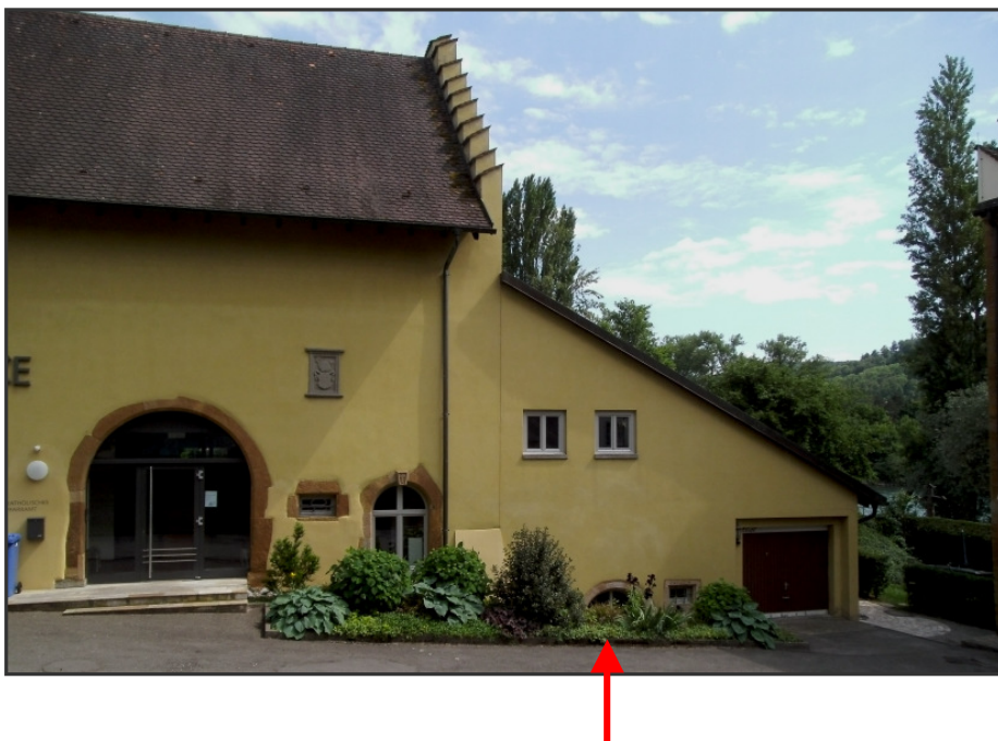
Begegnungszentrum „Die Brücke“: der rote Pfeil zeigt wiederum auf den ehemaligen Kellerabgang im Anbau.
