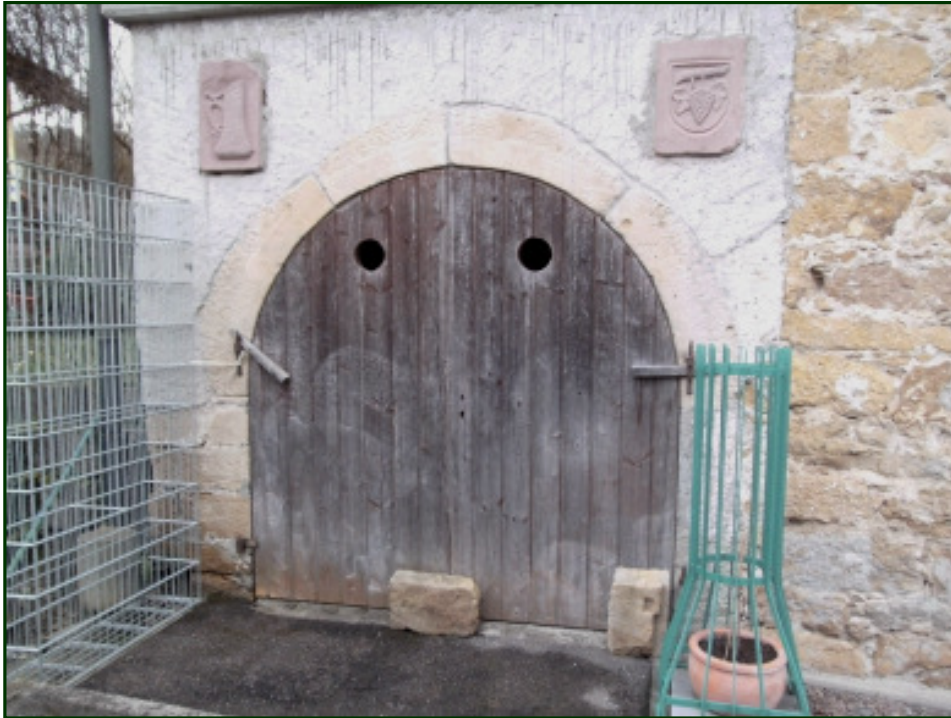
Tor des seitlichen Anbaus. dahinter liegt ein Kellerabgang an dem man die Jahreszahl 1733 und die Initialen MR findet Die Steintafeln aus rötlichem Sandstein sind neueren Datums
