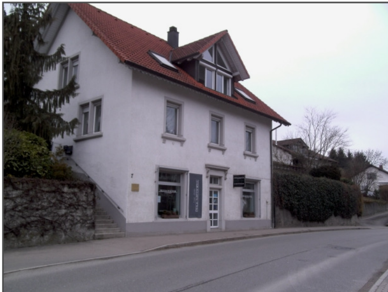
Das Gebäude in der Oberdorfstraße Nr. 7
