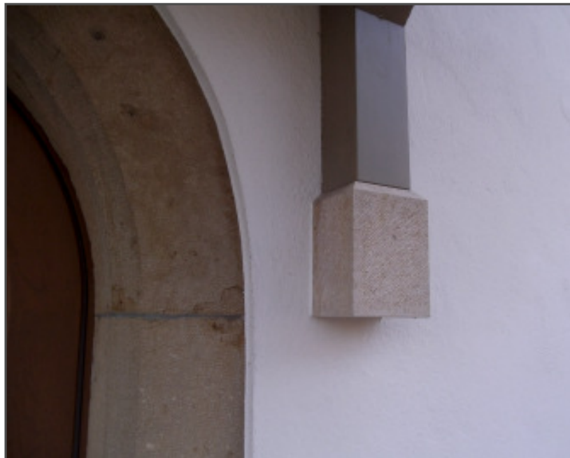
Konsole auf der sich das Vordach abstützt
