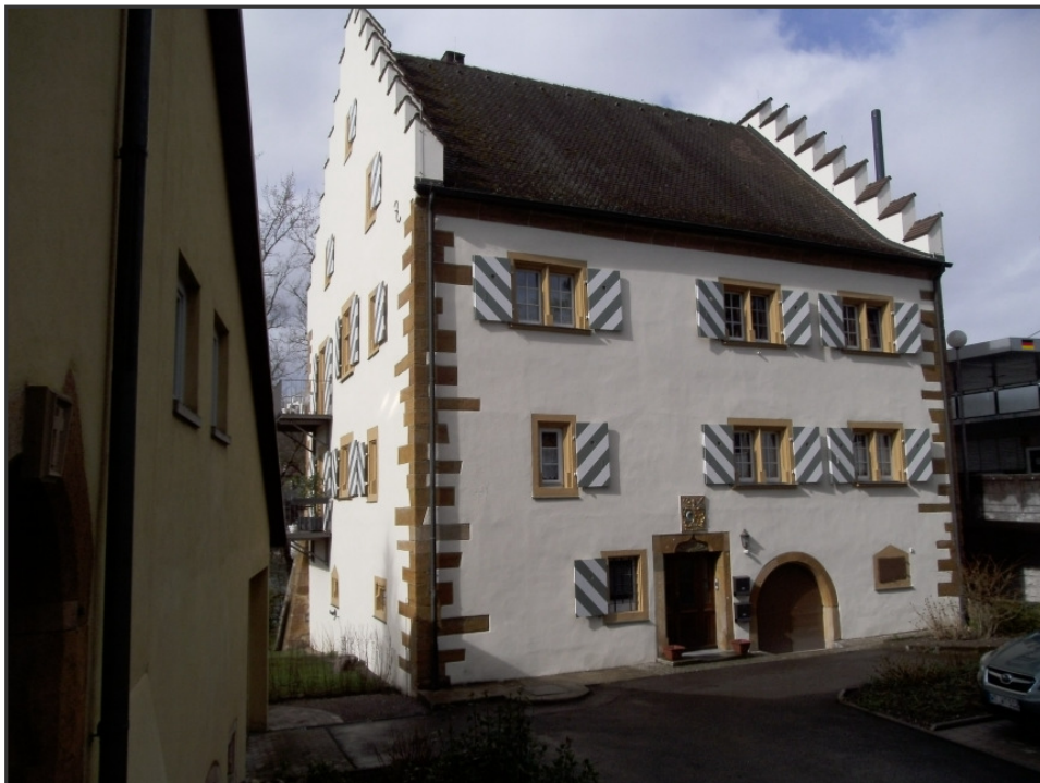
Das ehemalige Pfarrhaus mit dem hier beschriebenen Portal , rechts daneben Tür mit Rundbogen: Eingang eines Lagerraumes.
