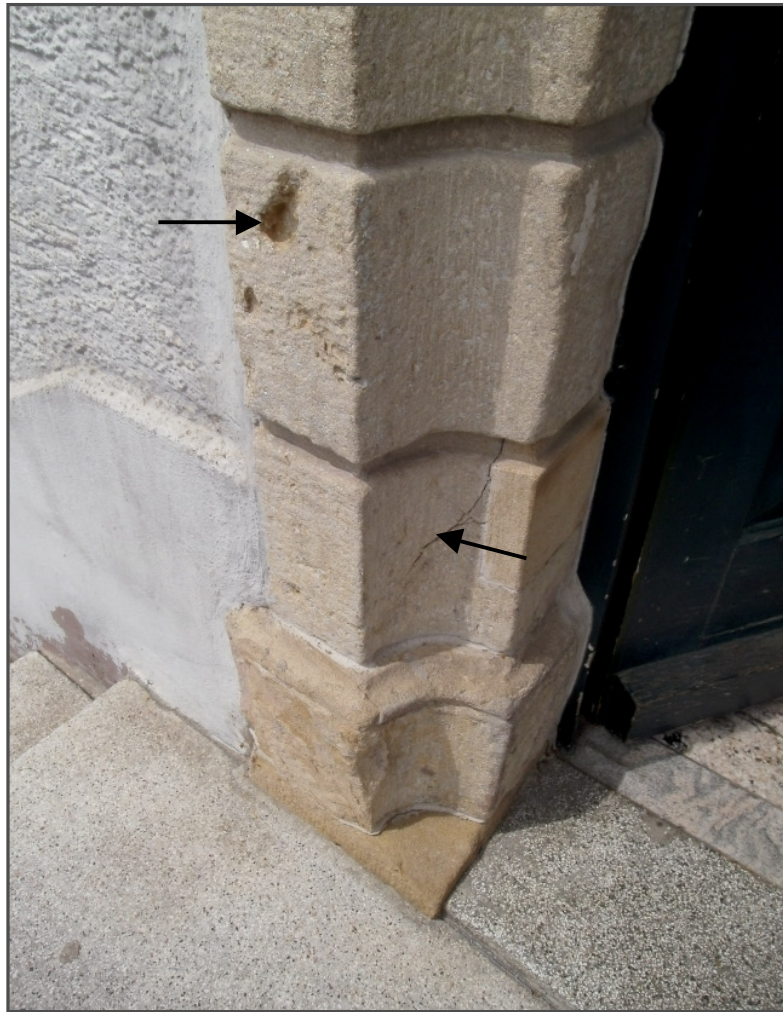
Frostschaden und Riss an der linken Türwange
