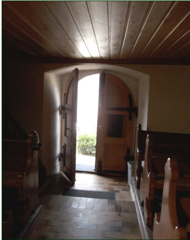
Die Tür von innen. Sie befindet sich in einer tiefen Türnische.
