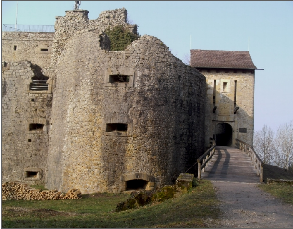
Ansicht der großen Bastion und des Torbaus von Osten
