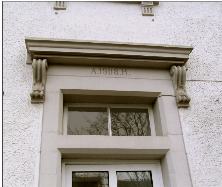
Das Gesims über dem Oberlicht der Eingangstür.
