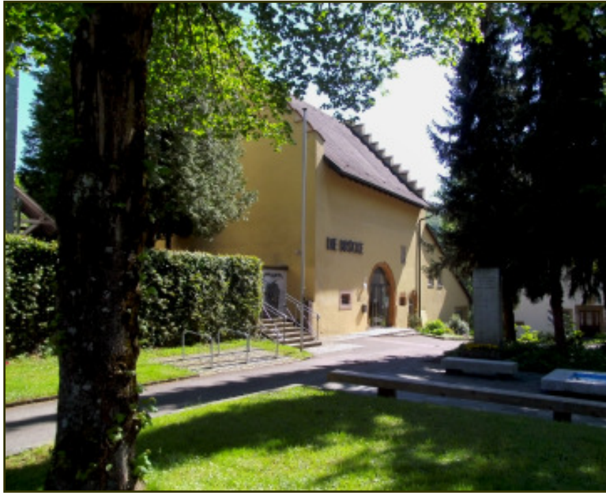
Das Begegnungszentrum von der Ortsmitte gesehen.
