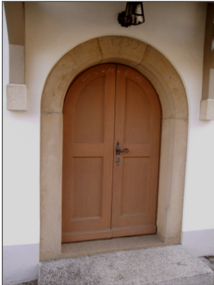
Ansicht des schön proportionierten Rundbogens
