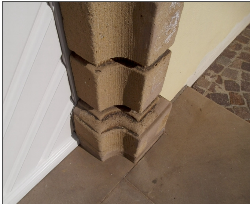
Hervorstehender Sockelstein, rechte Seite. Erfreulich ist, dass die Trittplatte aus dem selben Stein wie das Portal besteht.
