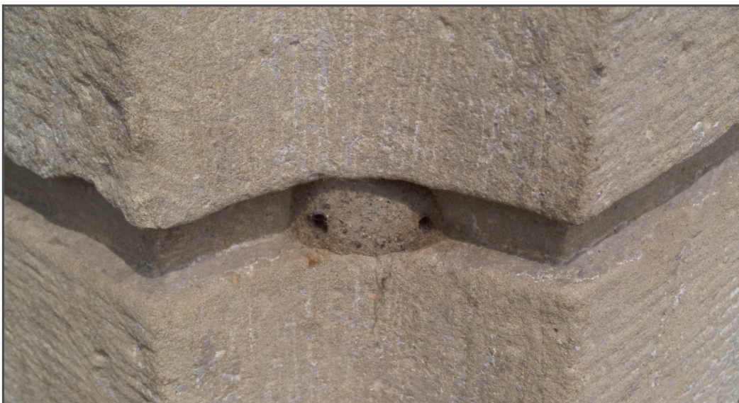
Frostschaden und Riss an der linken Türwange
