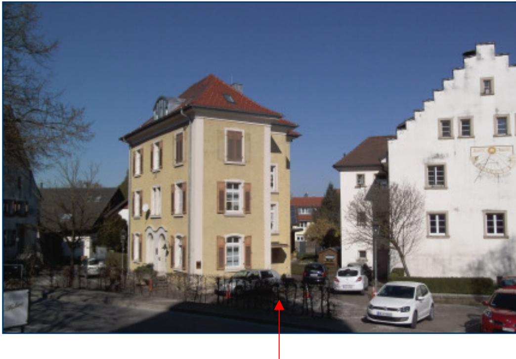
Das Zolldienstgebäude: der rote Pfeil zeigt auf die im Foto nicht sichtbare Tür. Das Ortszentrum ist auch an diesem Tag wie immer mit Autos zugeparkt. Rechts im Bild sieht man das alte Rathaus.
