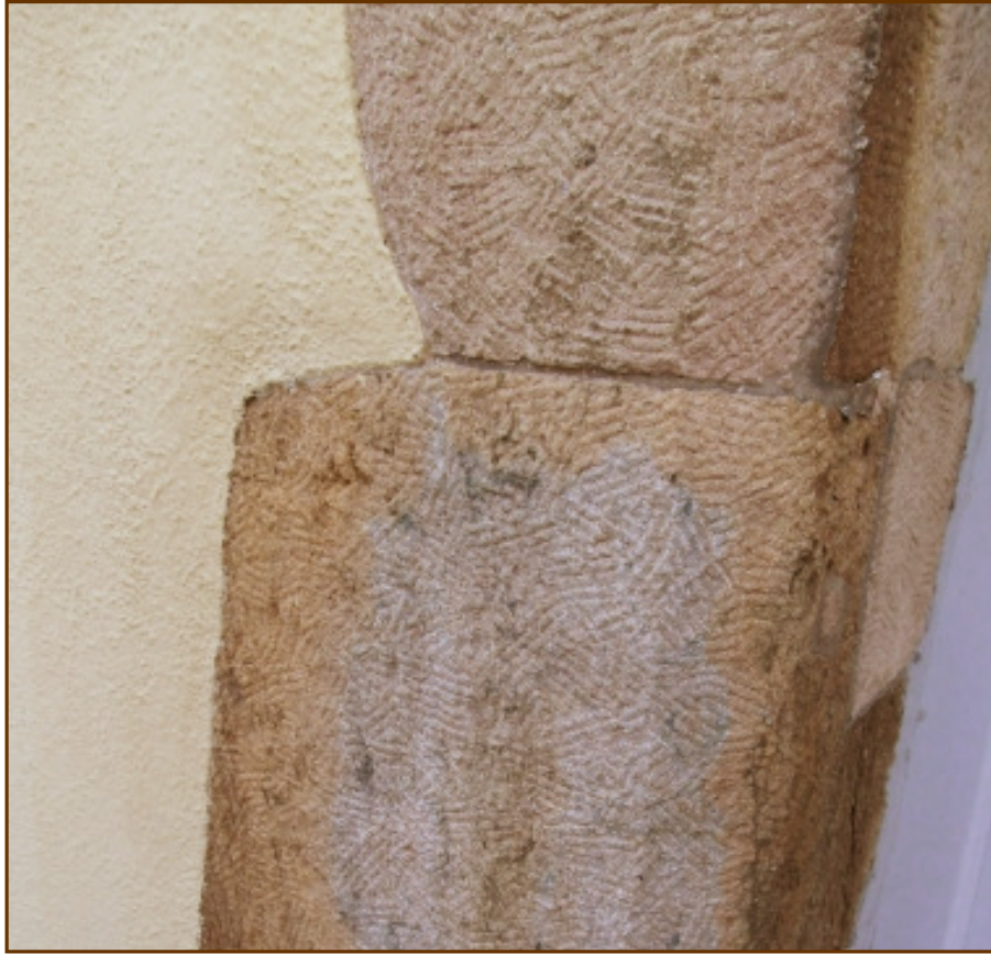
Falsche Überarbeitung der Bogensteine durch den Steinmetz
