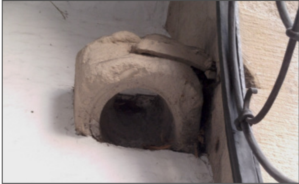
Der obere, rechte Lochstein mit eisernem Haltebügel. Von innen gesehen, teilweise vom Wandputz verdeckt.
