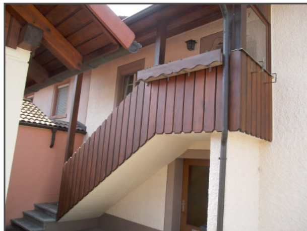
Die Außentreppe vom Hof aus
