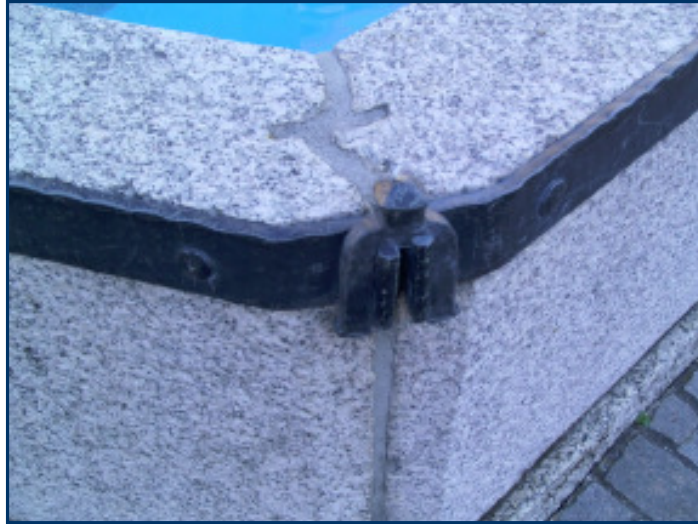
Abdichtung und Verklammerung der Ecken
