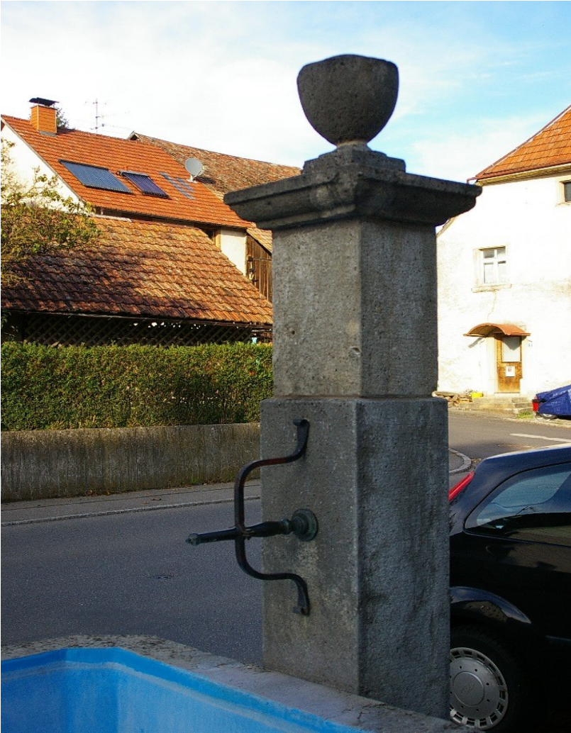
Kleine Beschädigungen am Säulenaufsatz, aber guter Allgemeinzustand
