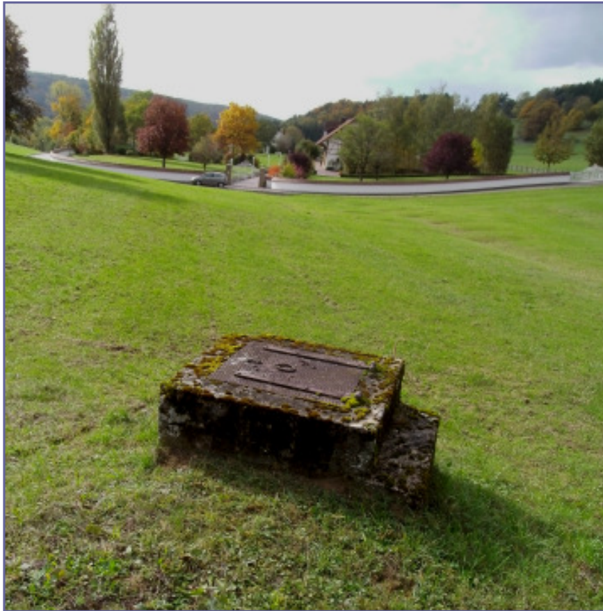
Schacht der alten Quellfassung, die einst den Alkenhof versorgte. Im Hintergrund der Alkenhof mit seiner großen Umfassungsmauer.
