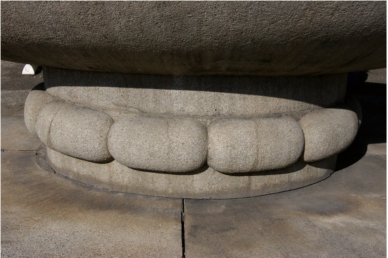
Stabiler Sockel auf einer der Brunnenform entsprechenden ovalen Betonplatte mit 3m Durchmesser
