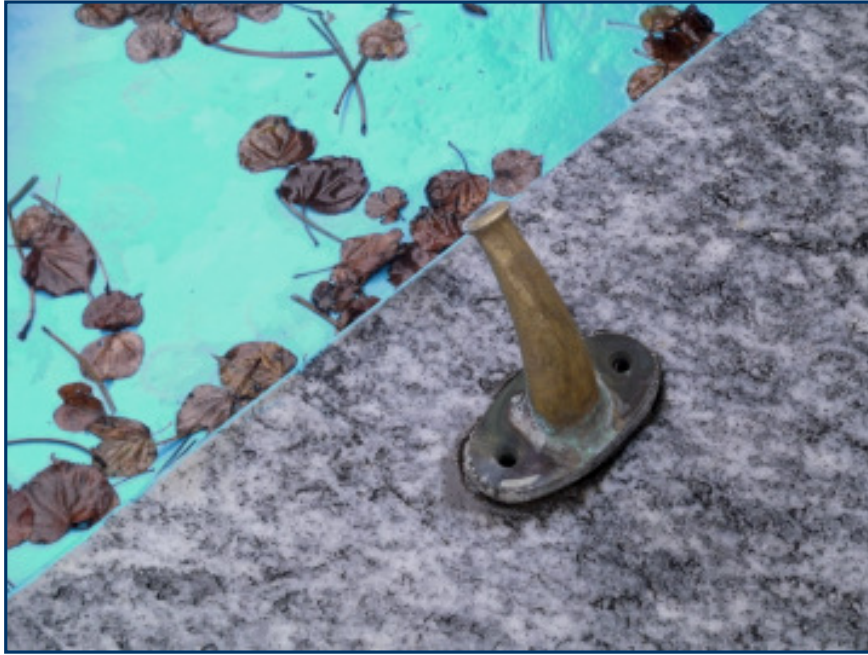
Der Wasserzulauf des Beckens, hier bereits für den Winter abgestellt.
