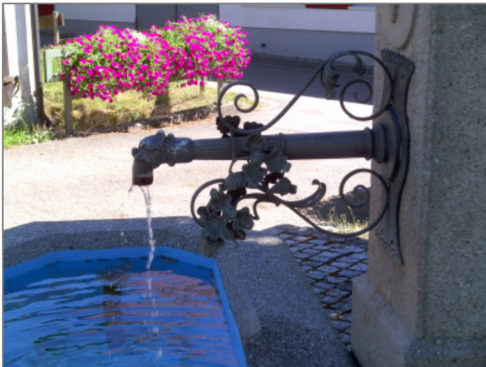
Brunnenbecken und Auslauf aus anderer Perspektive. Auch diese Aufnahme macht deutlich, dass das Blau der Innenbeschichtung zu grell und damit zu dominant ist.
