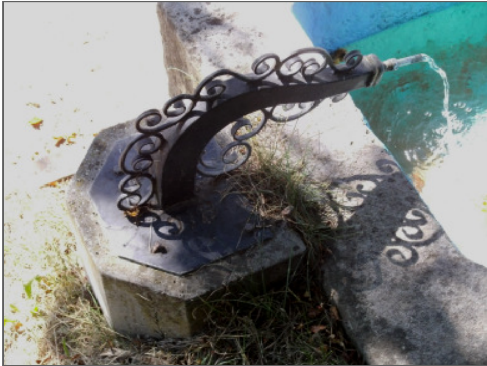
Der Einlauf des Brunnens mit dem 1994 angefügten Schächtchen und dem schmiedeeisernen verzierten Zulaufrohr.
