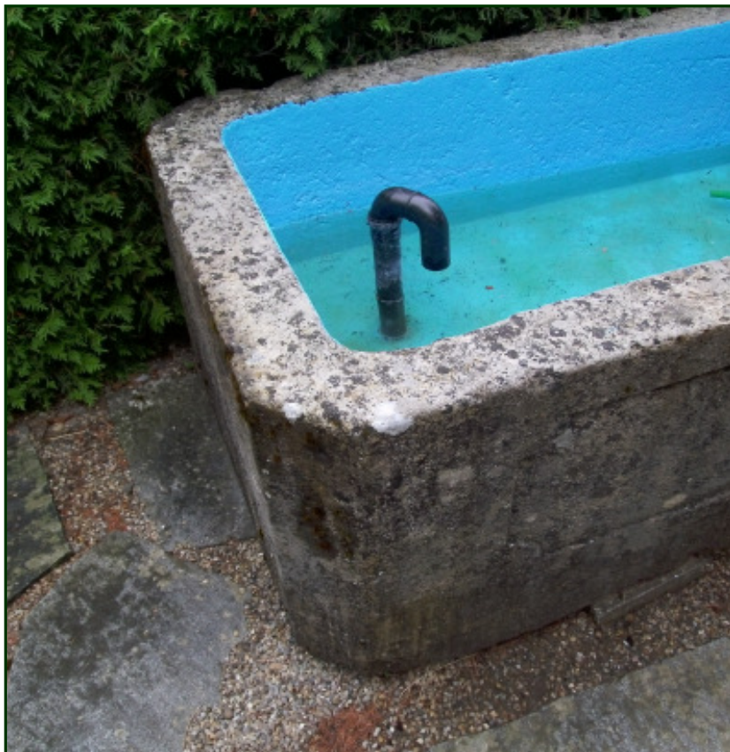
Der Auslauf des Brunnens taucht von oben in das Wasser ein. Auf dem Bild sieht man auch die abgeschrägten Ecken des großen Troges.
