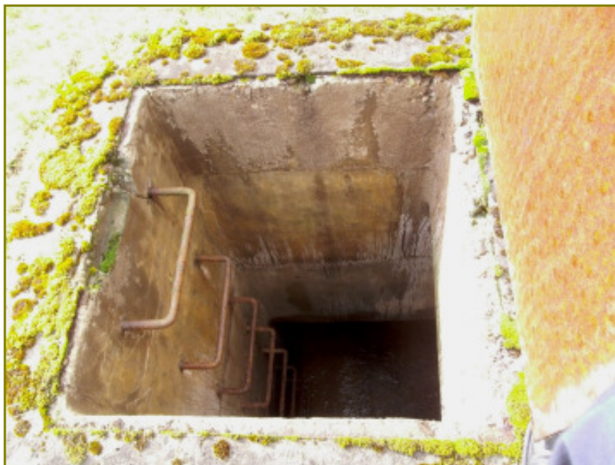
Blick in die alte, nicht mehr genutzte tiefe Quellfassung.
