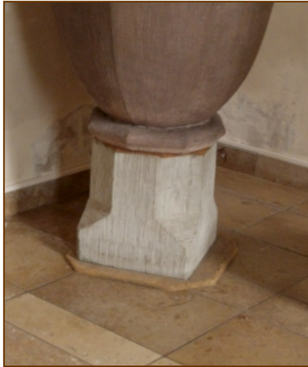
Der betonierte Sockel mit den als Unterlage dienenden Faserplatten und dem Fußboden aus Solnhofener Platten.
