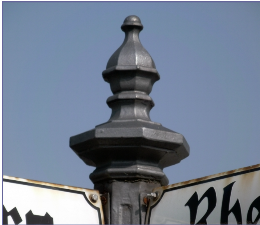
Die aufgeschraubte Spitze, die ebenfalls aus Guss besteht.
