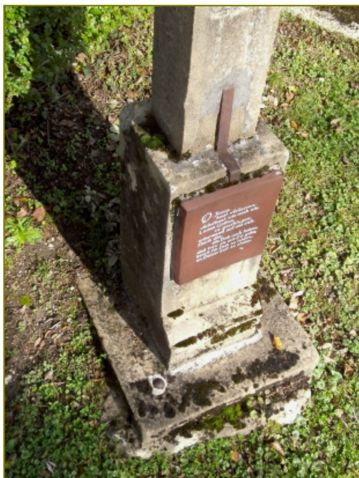
Sockel des Kreuzes mit Messbolzen ( links vorne )
