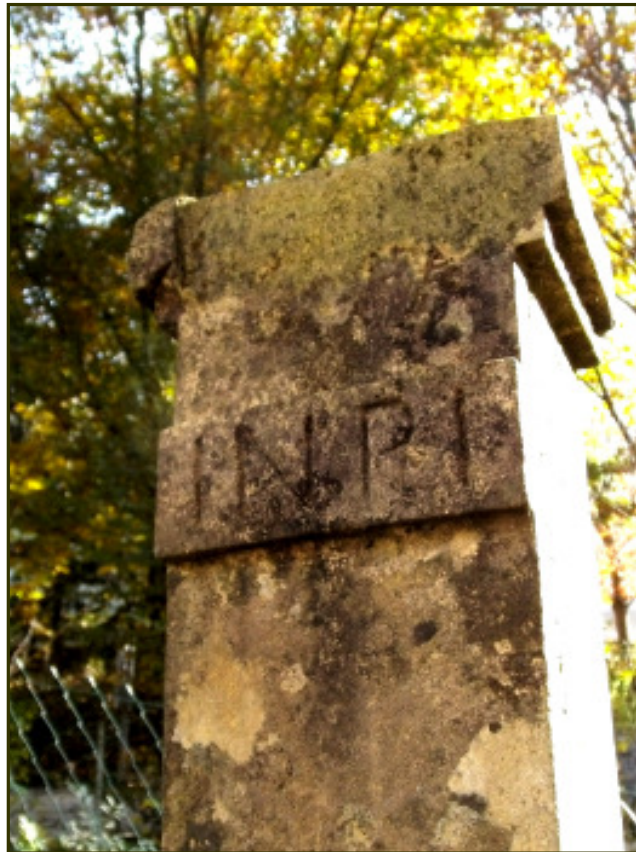
Ansicht der beschädigten Spitze
