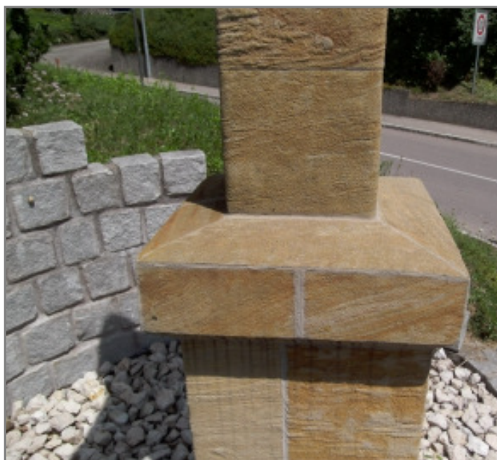
Mit Steinplatten verkleideter Sockel
