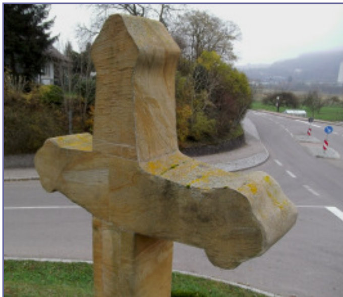
Die kleeblattförmigen Arme des Kreuzes. Aus der Nähe gut zu erkennen ist der tapetenartige Putzauftrag mit beginnenden Schäden an den Kanten
