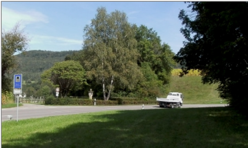
Ansicht der kleinen Anlage von Südwesten. Im Vordergrund die Landstraße L 162
