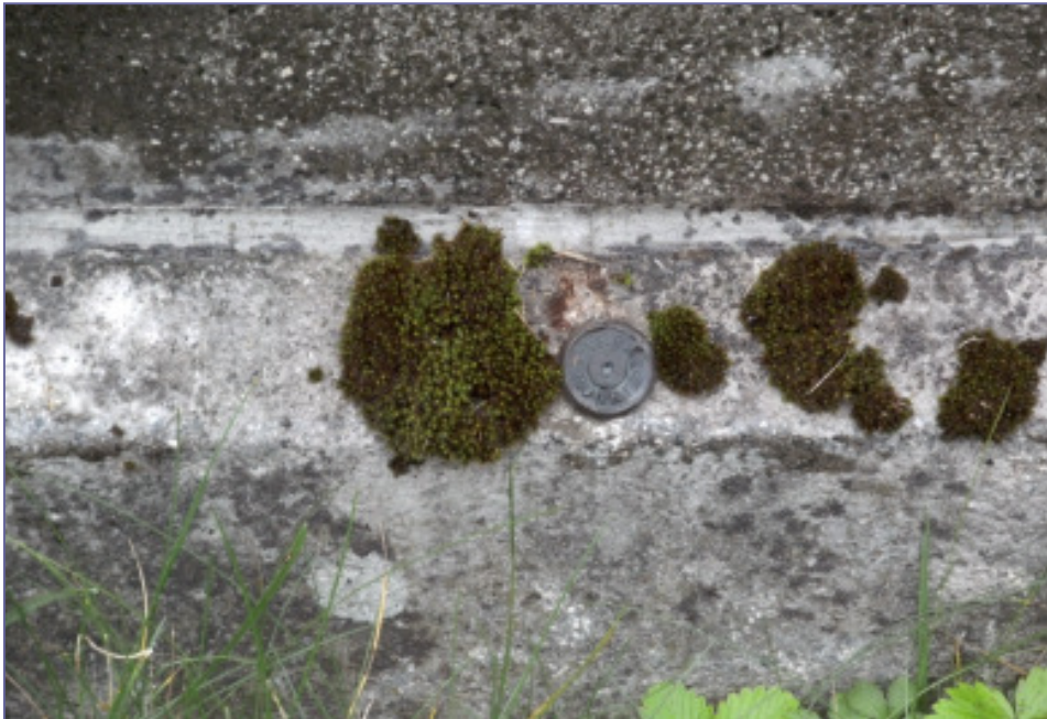
Messbolzen am untersten Sockel
