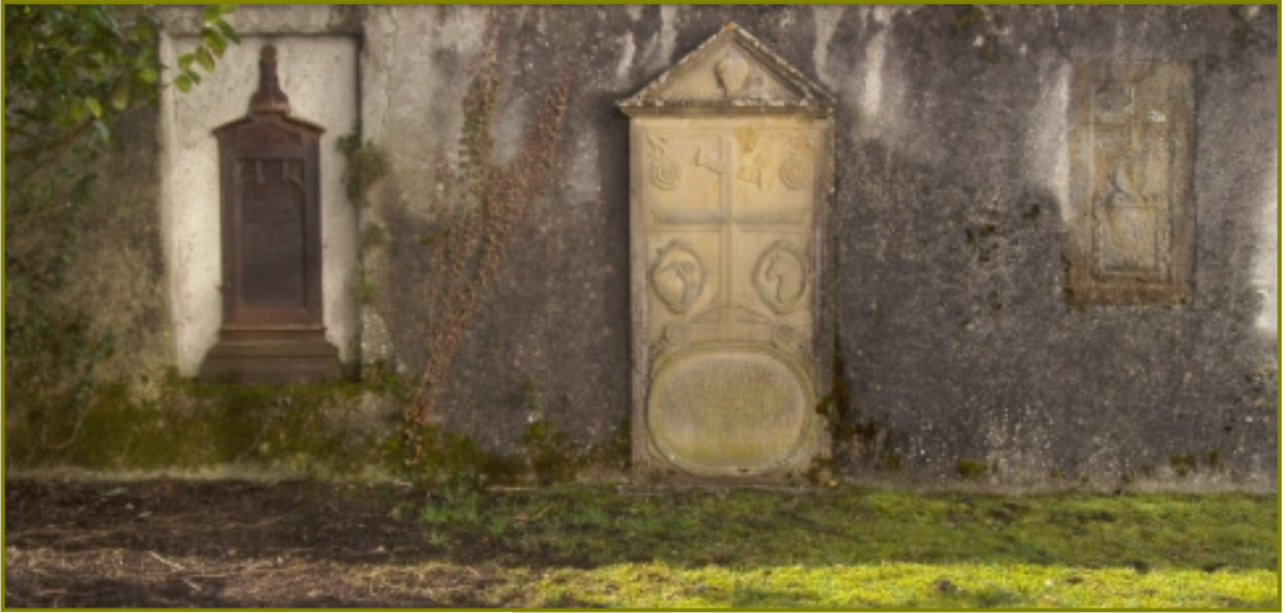
Die westliche Friedhofsmauer
