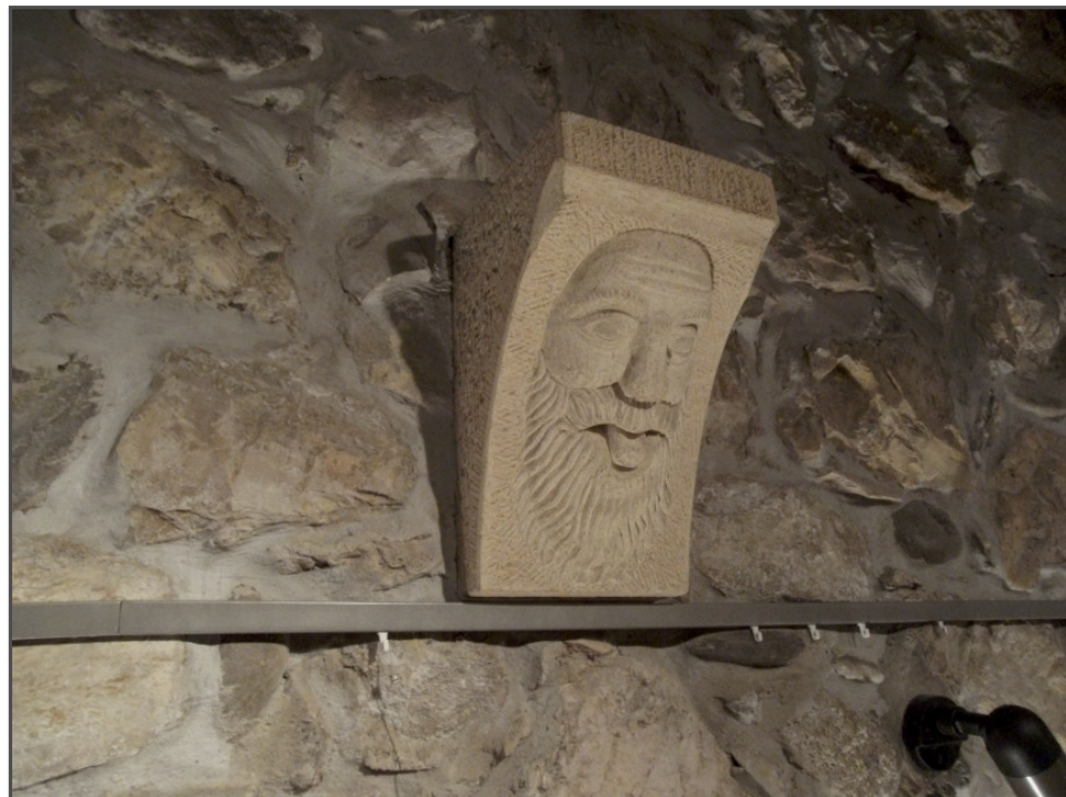
Die Konsole sehr beeinträchtigt durch die nahe vorbei führende Schiene, die man besser hier unterbrochen hätte.
