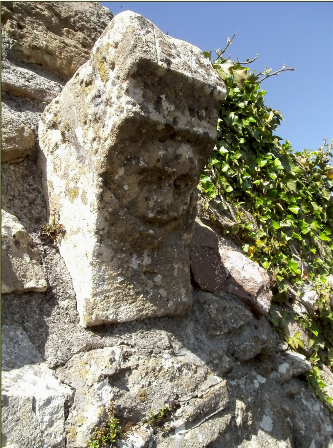
Die Konsole in Nahaufnahme. Man beachte den Flechtenbewuchs.
