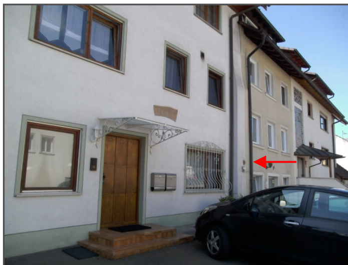
Typische Dangstetter Situation: Vorgärten beseitigt, Flächen asphaltiert und zugestellt mit Autos.
