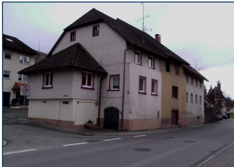
Das ehemalige Scharfrichterhaus. Bei genauem Hinsehen erkennt man an der vorderen „rechten“ Hausecke den Steinmann, links daneben das Fenster mit der Jahreszahl 1615. Die drei zusammen gebauten Häuser sind eine typisch mittelalterliche Häuserzeile.
