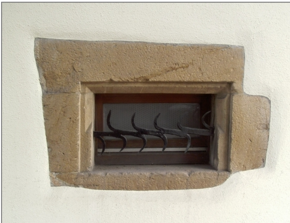
Fenster „rechts“ vom Haupteingang, an der Nordwestecke.
