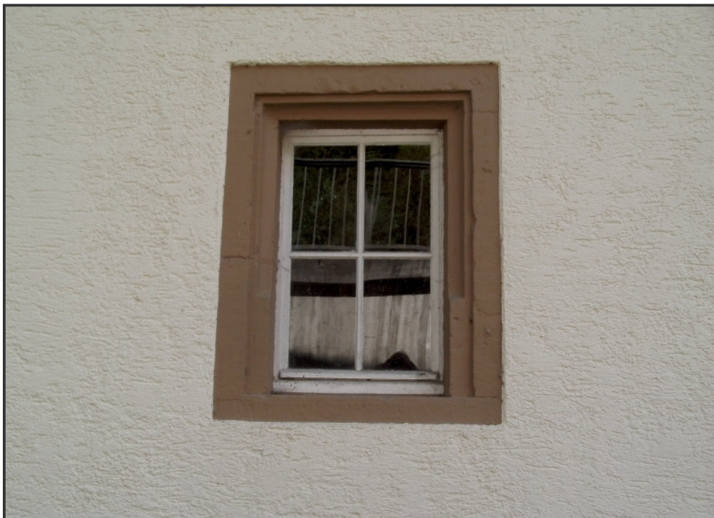
Eines der kleineren Fenster mit gotischer Zierfase und Falz. Die ehemals vorhandenen Fensterläden wurden entfernt.
