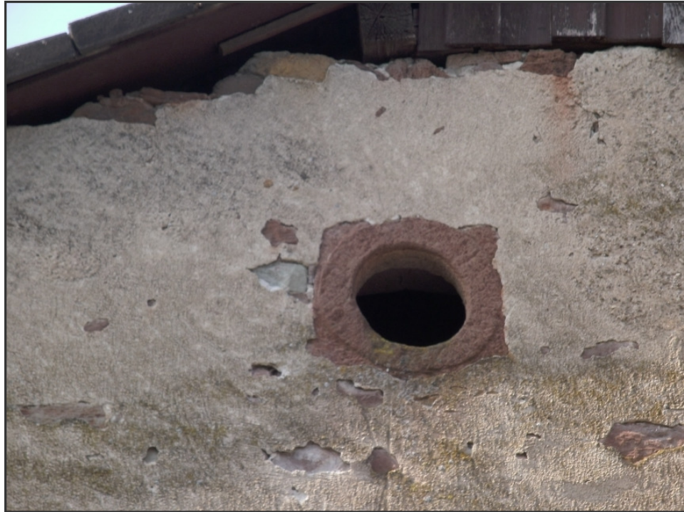
Das Fenster in dem aus rotem Sandstein bestehenden Mauerwerk, das einst vollständig verputzt war.
