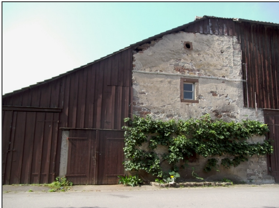
Die Gesamtsituation: Scheunenwand und Rundfenster. Kartiert Ende August / Anfang September 2014.
