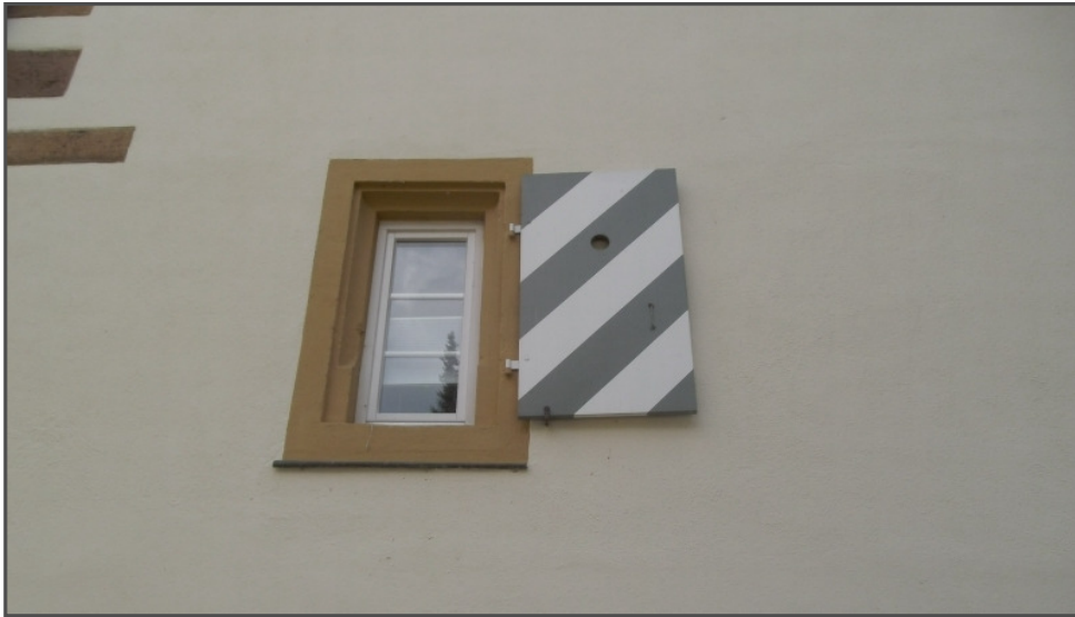
Einzelfenster mit bemaltem Klappladen auf der Eingangsseite im ersten Obergeschoss und links vom Haupteingang. Auch dieses Fenster hat unten eine Tropfleiste aus Kupferblech.
