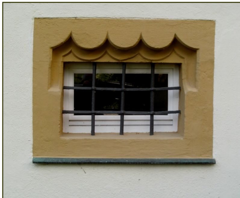
Zierfenster auf der Südostseite also „links“ vom Haupteingang Richtung Reckingen. Ein ähnliches Fenster fand ich nur noch im Elsass am Rathaus von Mülhausen. Das abgebildete Objekt hat folgende Abmessungen: Tiefe des Fensterfaches: 0,18 m. Breite außen: 1.07 m, Höhe außen: 0,825 m. Lichte Weite innen: 0,74 m, lichte Höhe innen: 0,45 m.
