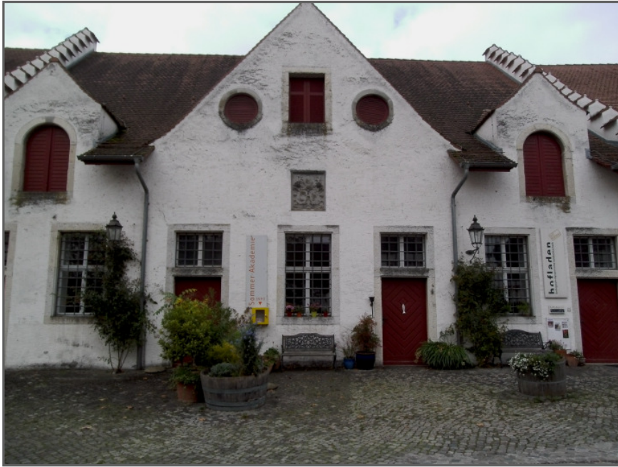
Kloster Rheinau im Kanton Zürich / CH : Rundfenster an den ehemaligen Stallungen – zweite Hälfte 16. Jhd.
