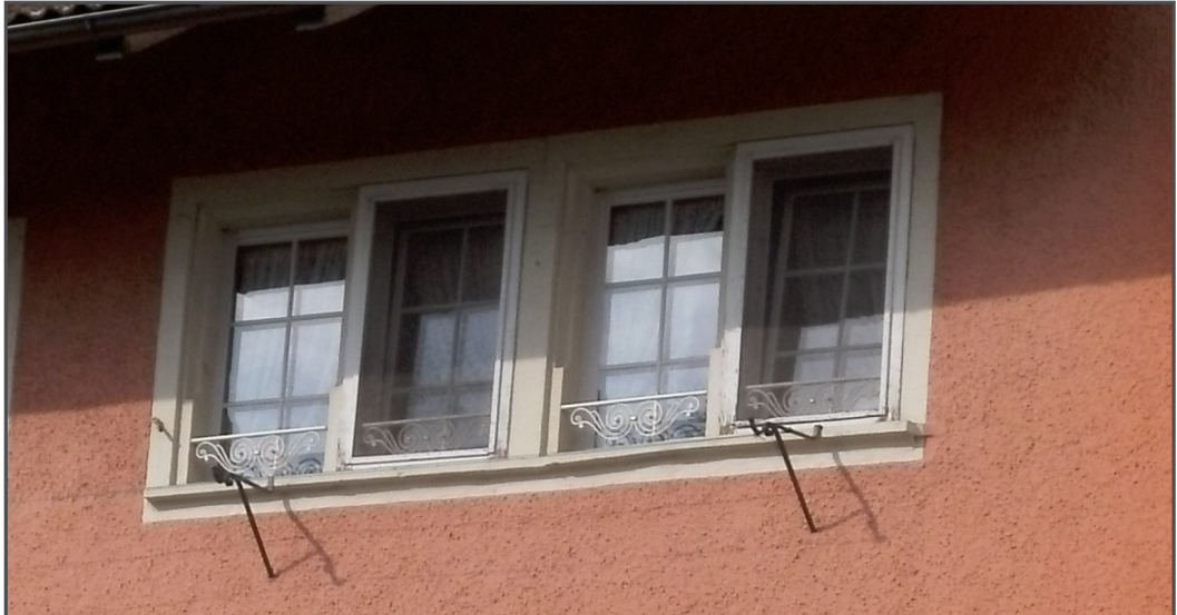
Das Vierfachfenster auf der Rheinseite in vergrößerter Darstellung. Es hat zwei schmale Stege an den Seiten und einen verstärkten Mittelsteg. Durch die beiden Fliegenschutzgitter ist die Fensterumrandung teilweise verdeckt.
