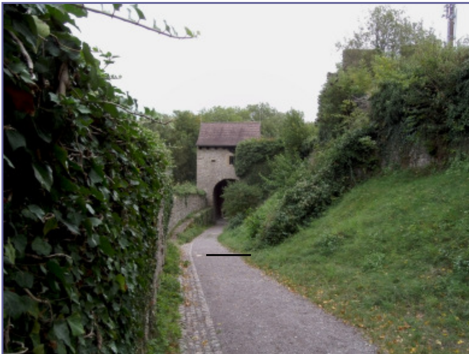
Rechts der Bildmitte erkennt man die efeubewachsenen Reste der Mauer, die einst die beiden Zwinger trennte. Im Hintergrund ist das wieder aufgebaute Torgebäude zu sehen. Der helle Fleck im Mittelgrund ist die in der Datei beschriebene Schwelle.
